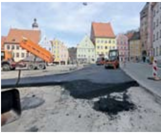
Aktuelle Aufnahmen der Arbeiten am Hauptplatz
