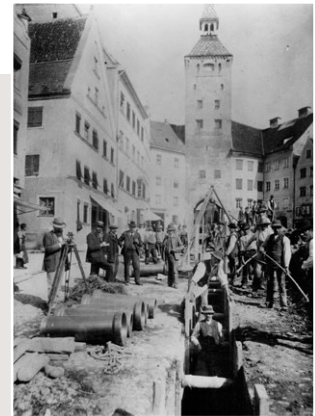
So sah das Verlegen der Anschlüsse beim letzten Mal aus.
